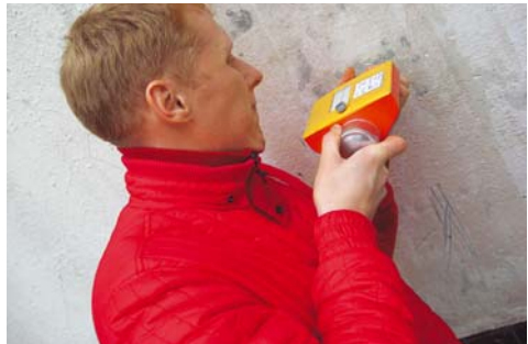
Визначення фізико-механічних характеристик будівельних конструкцій
